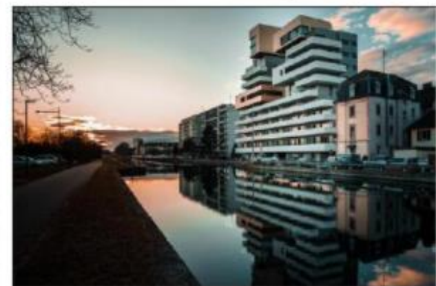
Pour mars : l'Almaleggo et son reflet dans le canal, une photo de Mehdi Boswingel. Le nouvel immeuble du quai de l'Alma a été conçu par l'architecte mulhousien Franco Viganotti. DR
