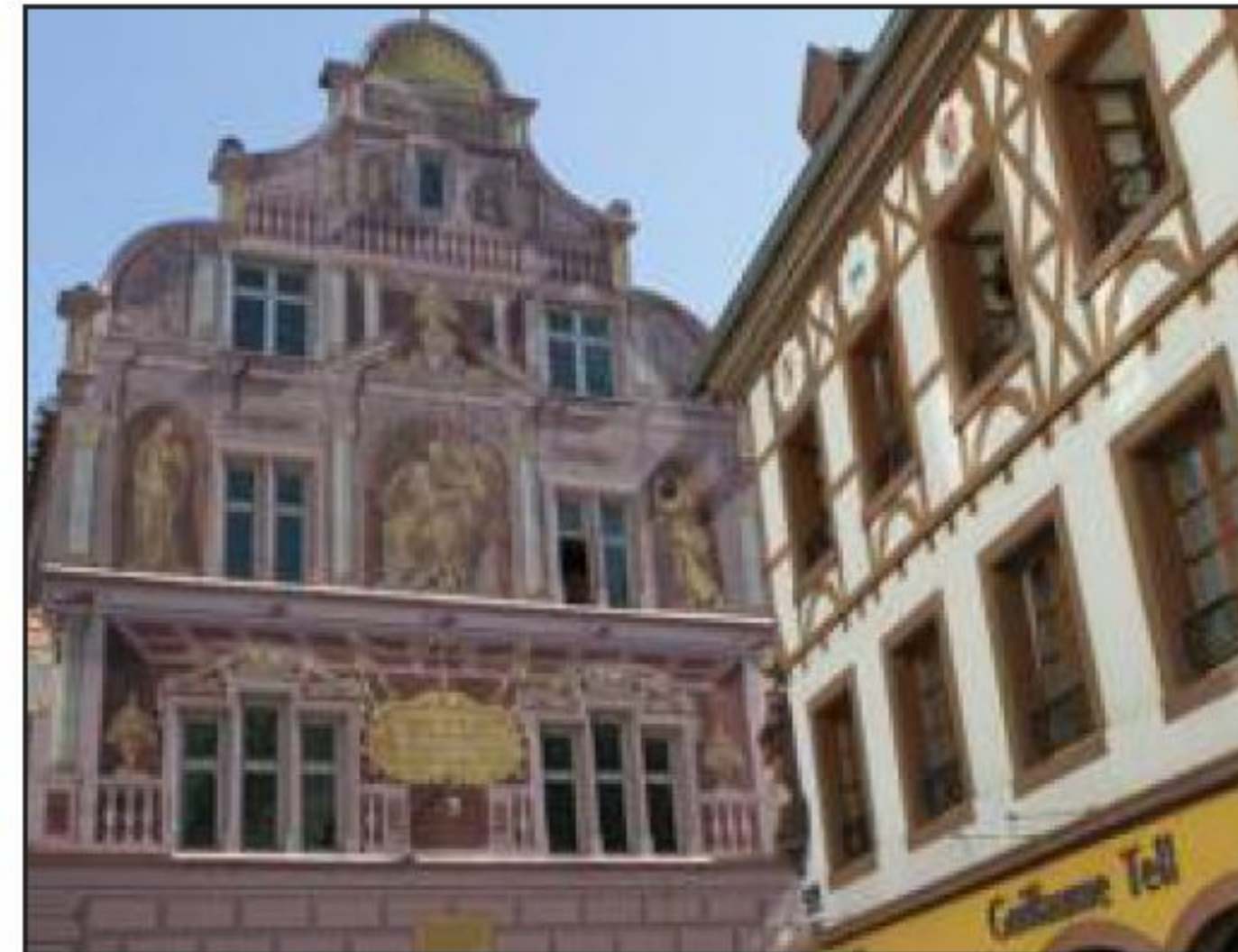
La toiture de l'hôtel de ville de Mulhouse pourrait bientôt être surmontée d'un nid de cigognes.
