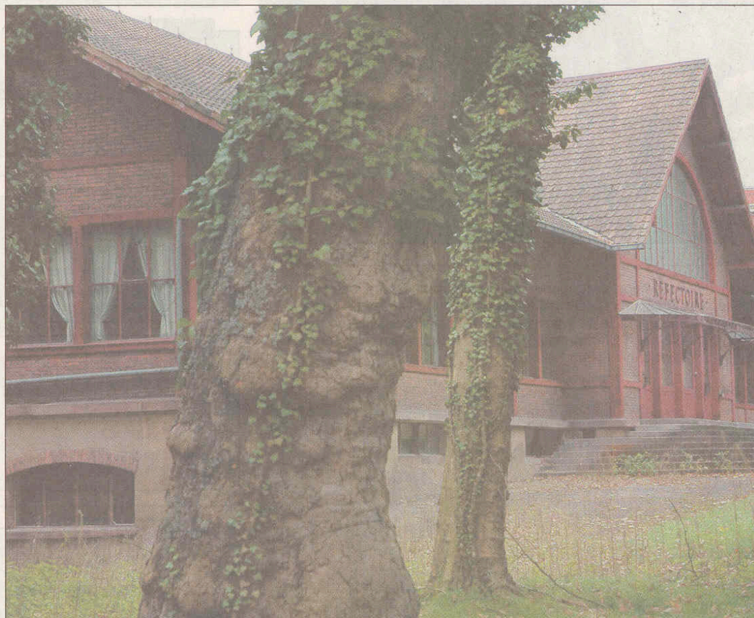
L'ancien réfectoire pourrait accueillir, tout naturellement, un ensemble de restaurants divers.
